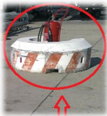
Figura 36 – Isola in cemento per estintori
