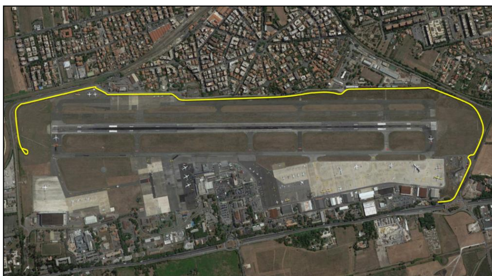
Ciampino, strada perimetrale
