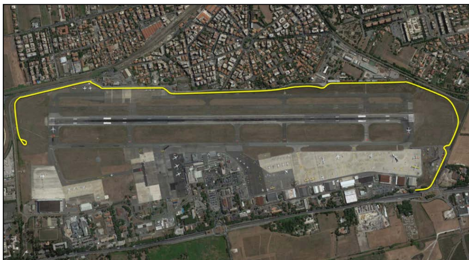
Ciampino, strada perimetrale
