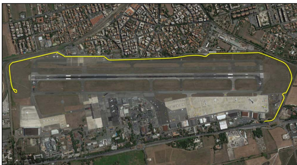
Ciampino, strada perimetrale
