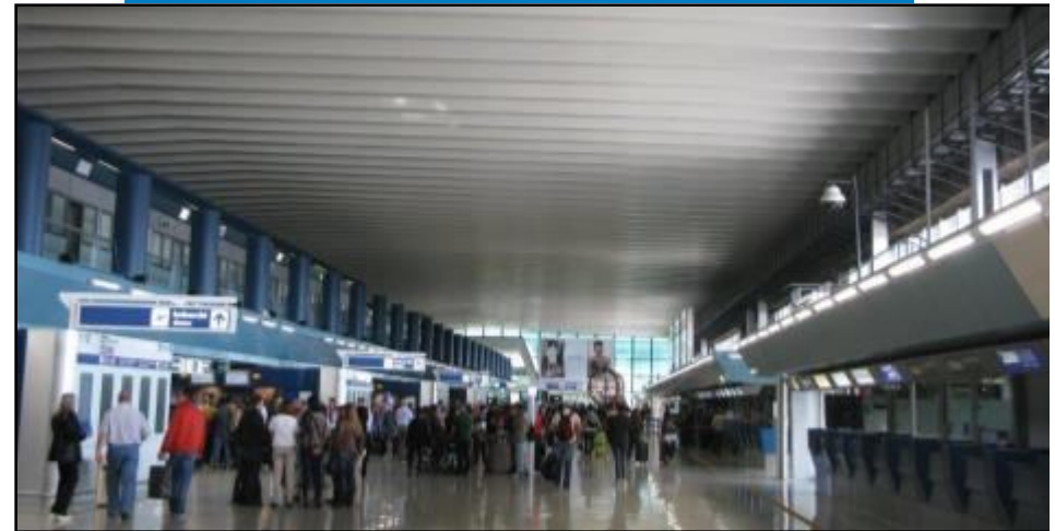
Verniciatura copertura metallica T3
