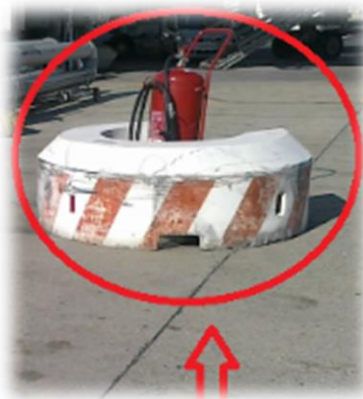
Figura 48 - Estintore collocato nelle piazzola (stand)
