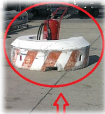
Figura 44 – Isola in cemento per estintori
