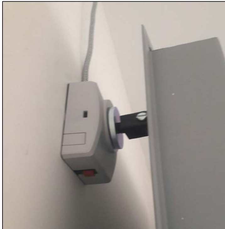
Pulsante rosso tramite cui sganciare la porta dall'elettrocalamita
