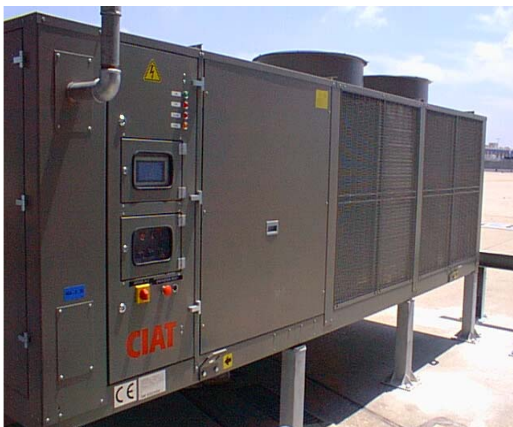
Foto n. 6 Pontili Parcheggi quadrante 800 (ex Kilo) – Impianto aria climatizzata
