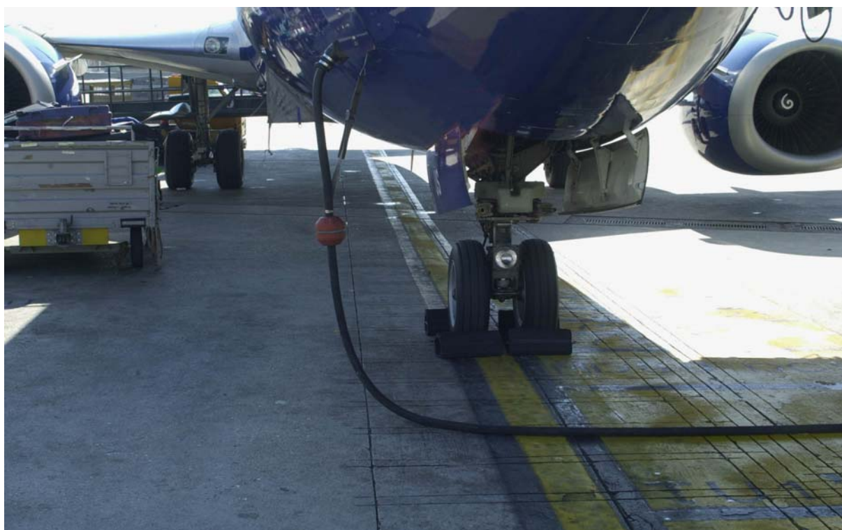
Foto n. 4 – Pontili Parcheggio quadrante 800 (ex Kilo) - Spina /pulsantiera 400Hz inserita nell'a/m
