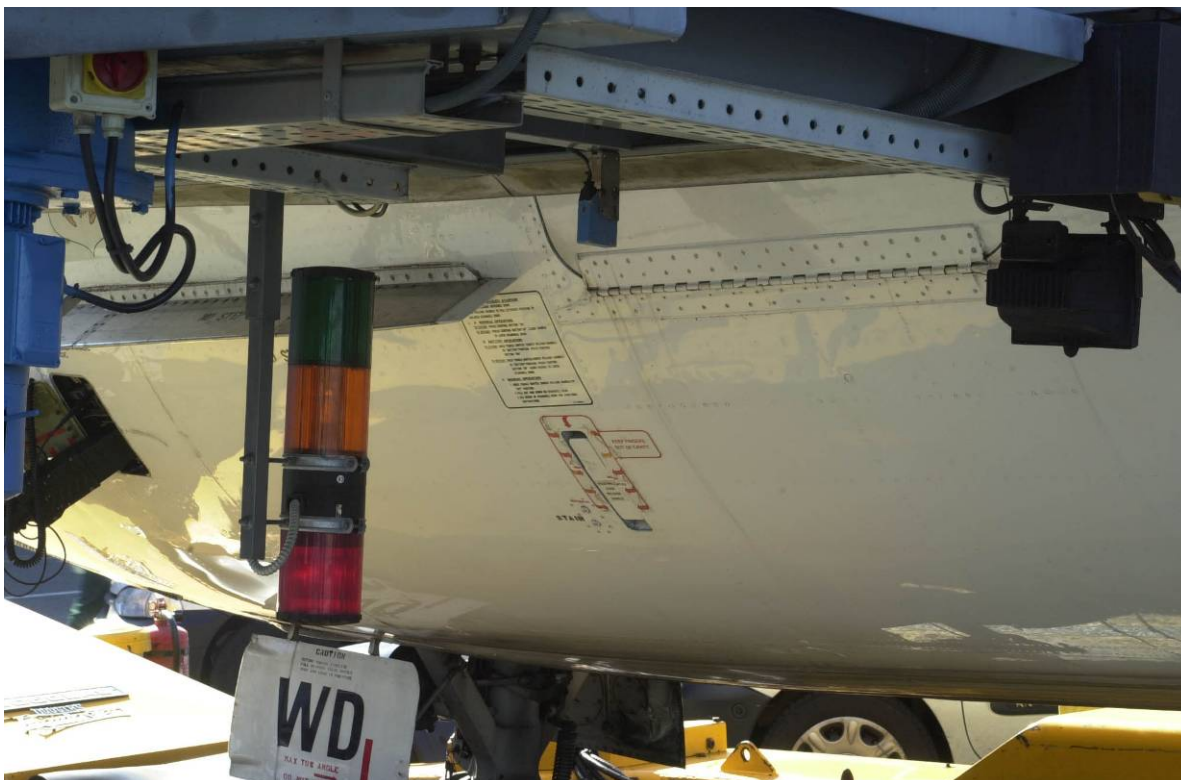
Foto n. 3 – Pontili Parcheggio quadrante 500 (ex Bravo) – Strumentazione esterna al pontile (semaforo )
