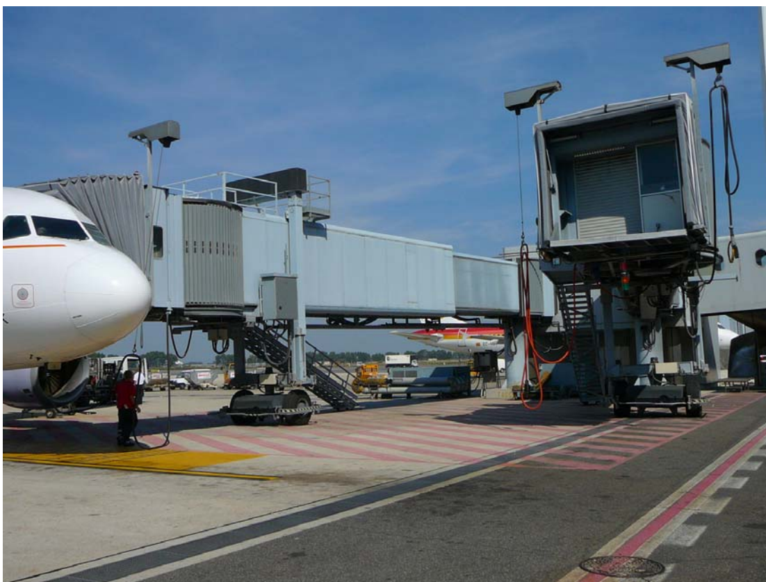
Foto n. 4 – Pontili Parcheggio quadrante 500 (ex Bravo) – Pontile a doppio braccio ( Apron Drive)
