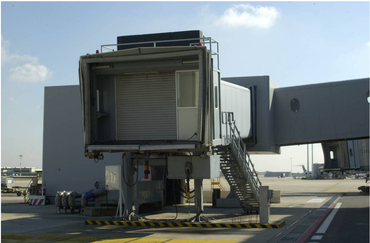
Foto n.5 – Pontili Parcheggio quadrante 500 (ex Bravo) – Pontile a braccio unico in posizione di riposo (Pedestal)
