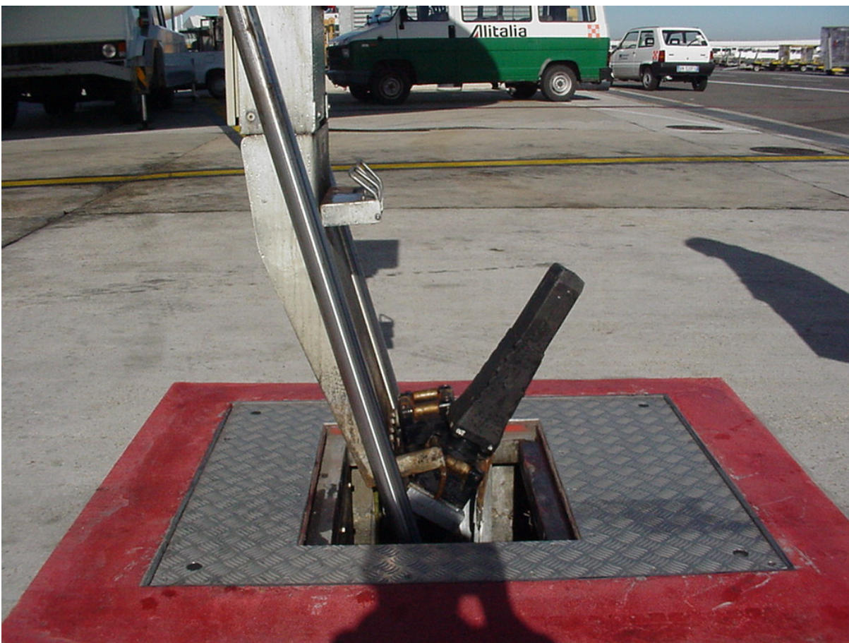
Foto n 4 - Parcheggi remoti 800 (ex Whiskey) – Pozzetto 400Hz con spina sganciata dal supporto
